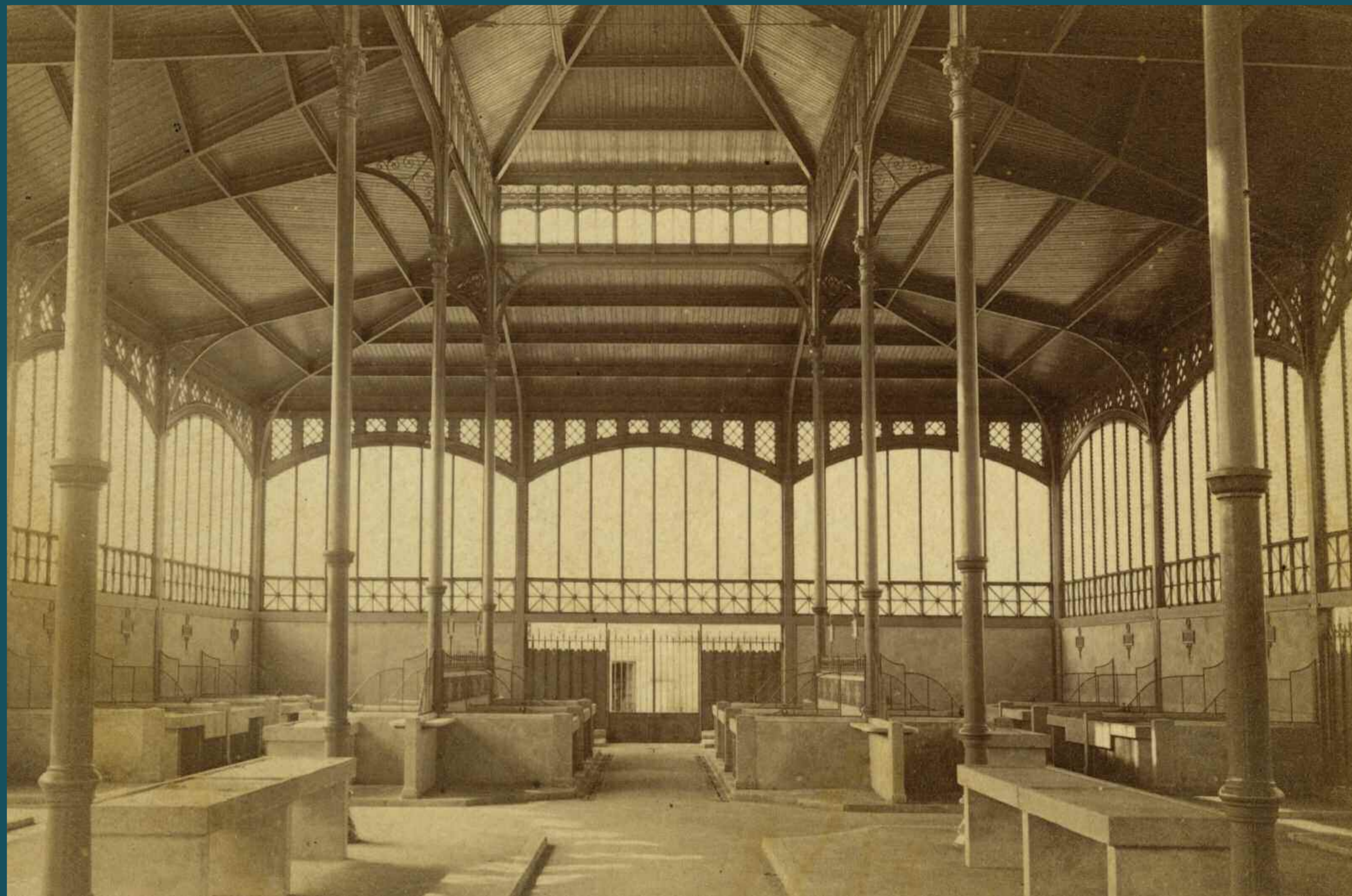
Les anciennes halles d'Évreux à l'emplacement de l'actuel parking du Général-Leclerc, fin XIX e siècle
